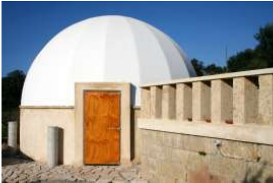
La cupola in muratura da 6 metri di diametro ospita un planetario a doppia tecnologia analogica + digitale 3D
